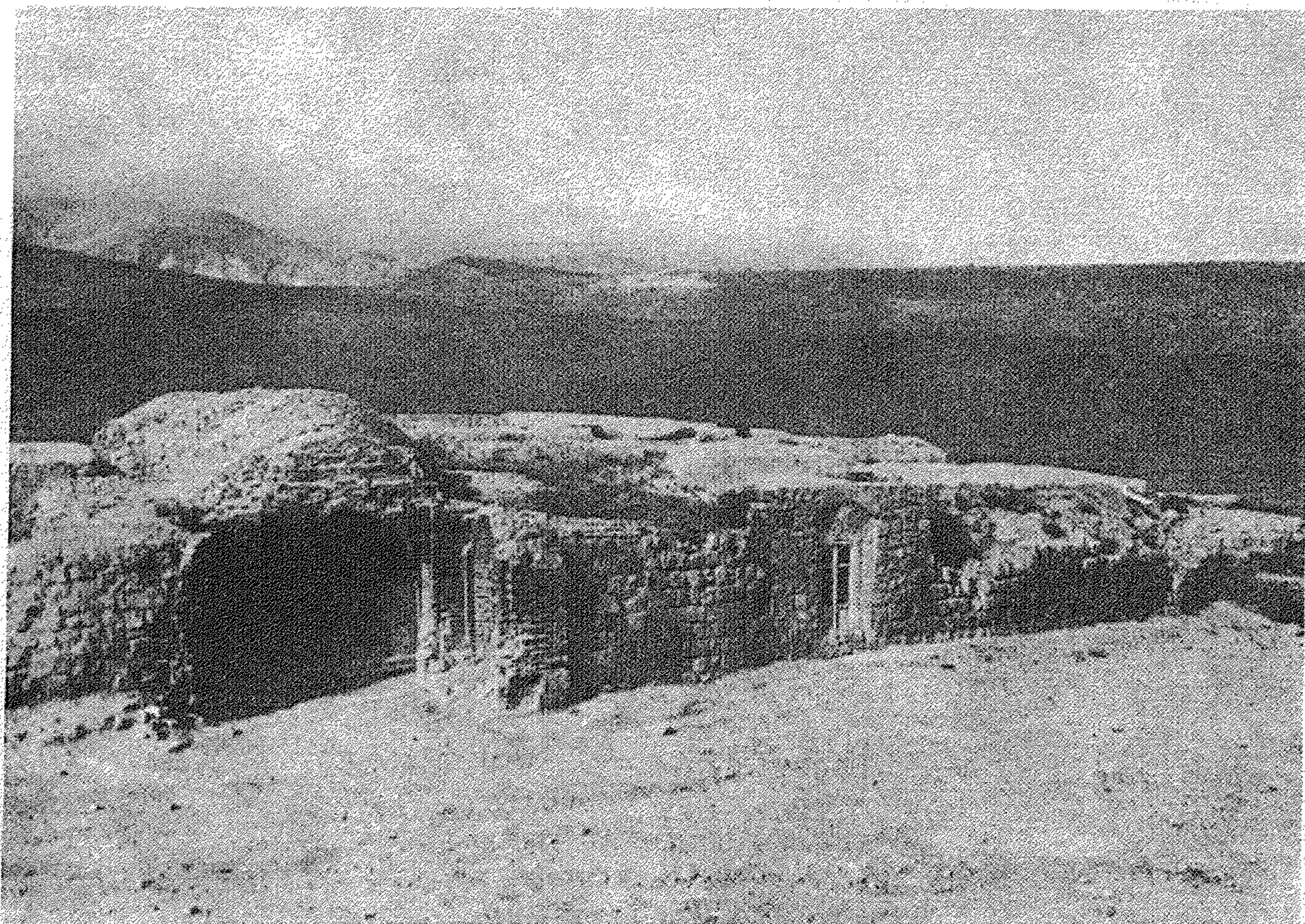
۸۱- کاروانسرای خرابه در ۲۷ کیلومتری جنوب غربی اهر
